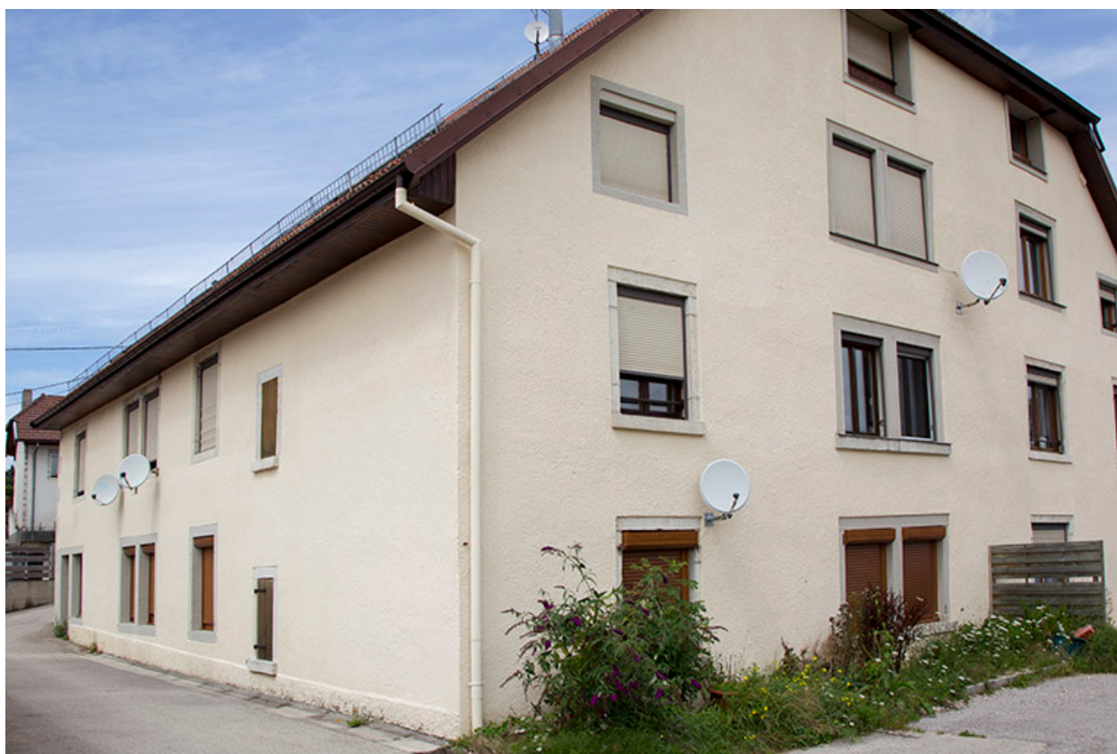
Façades postérieure et latérale droite.
