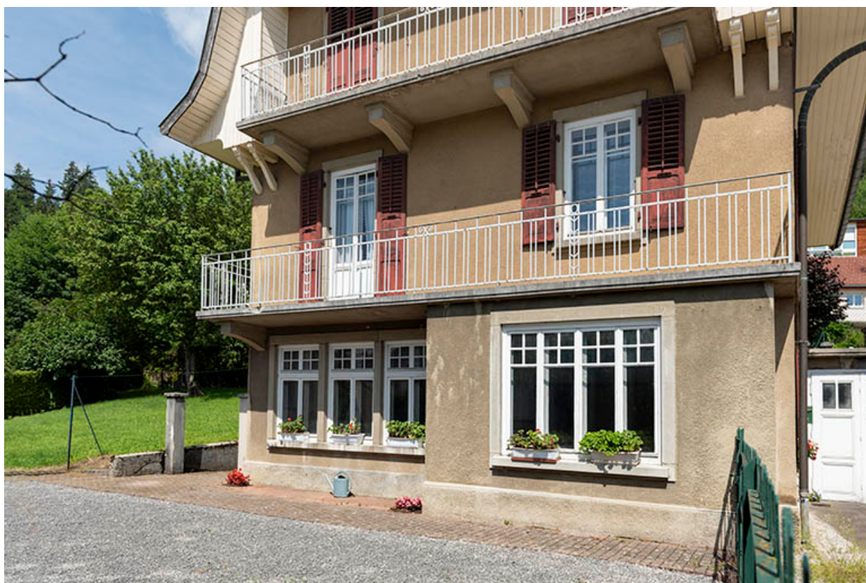
Façade antérieure : rez-de-chaussée et 1er étage.
