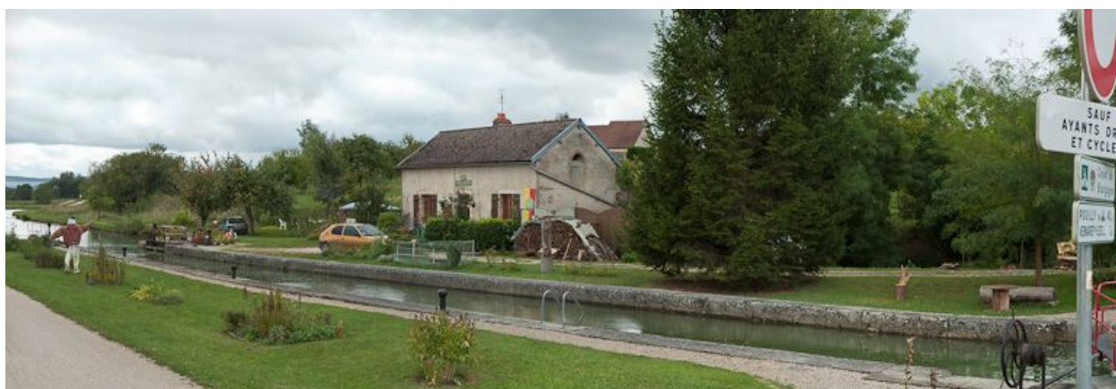
Vue d'ensemble du site d'écluse.
