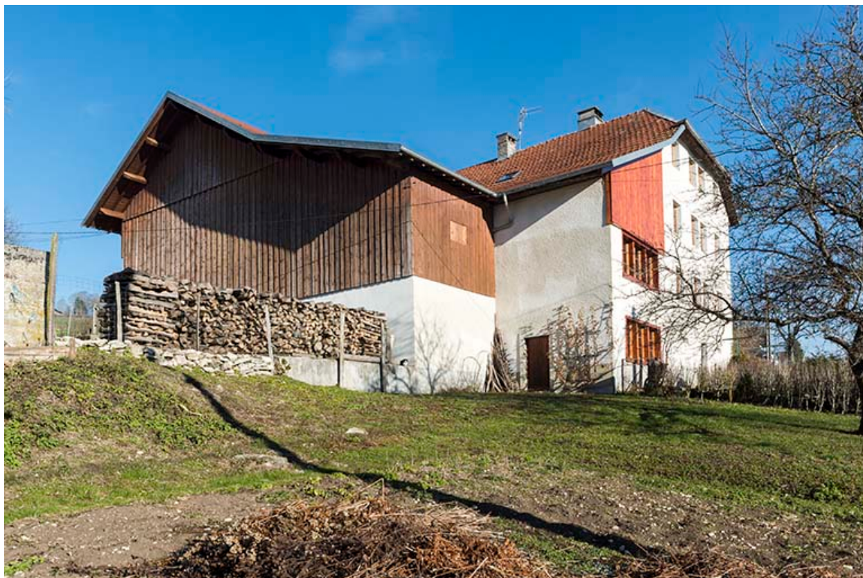
Façades postérieure et latérale gauche.
