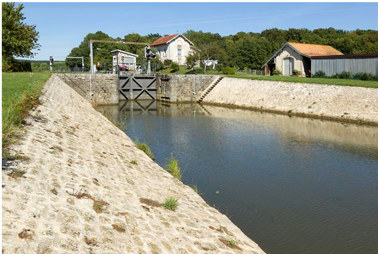
Vue aval du site d'écluse.
