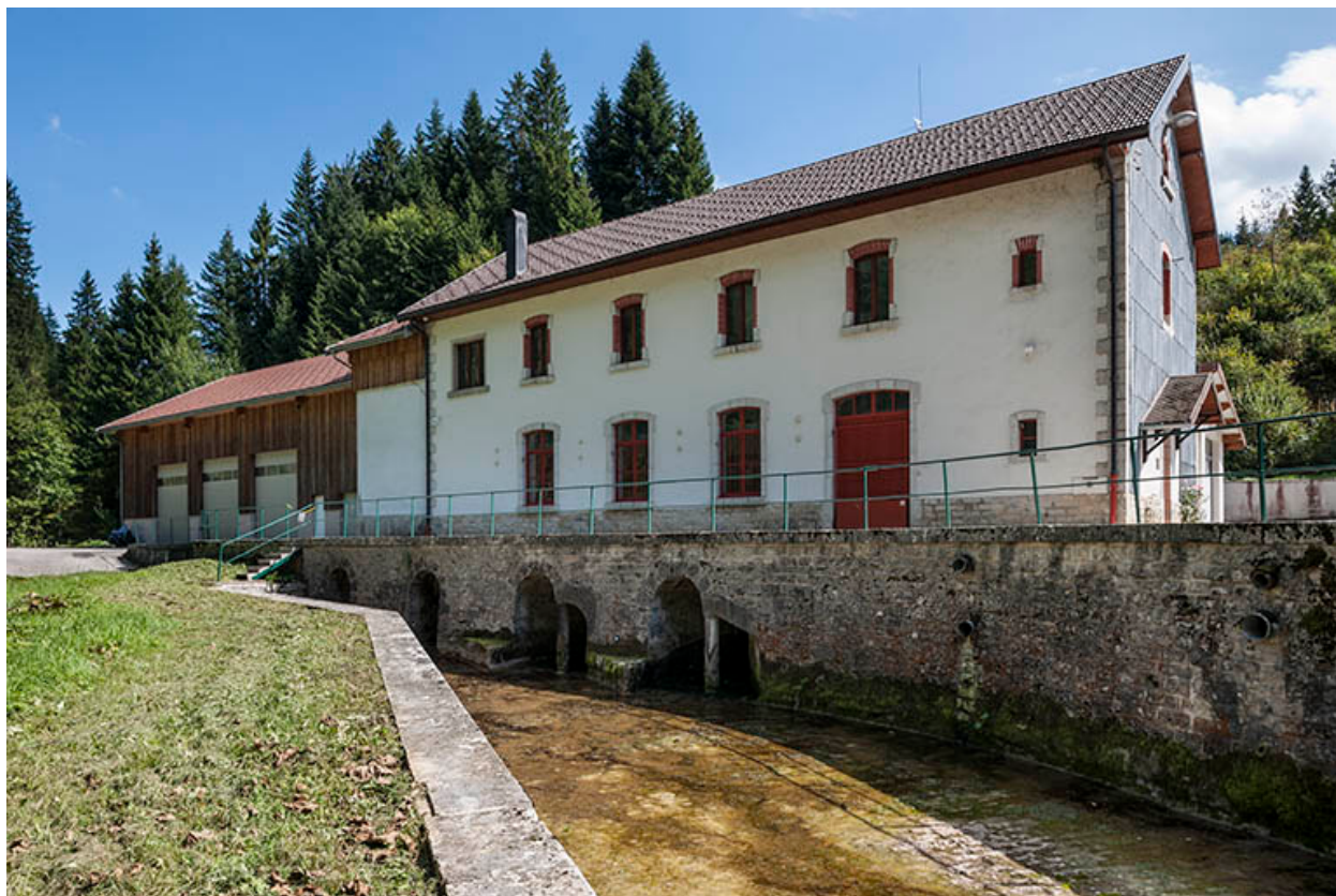
La centrale et le canal de fuite.
