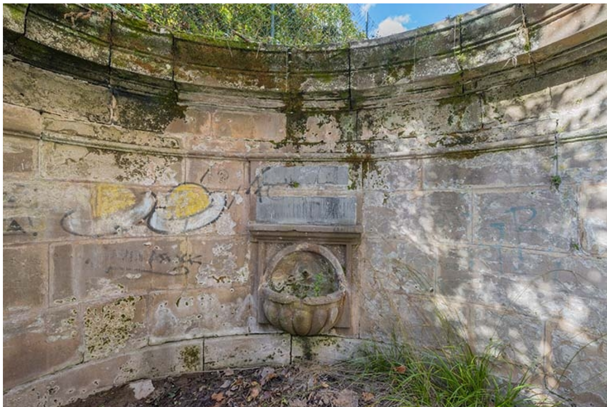
Mur de soutènement.
