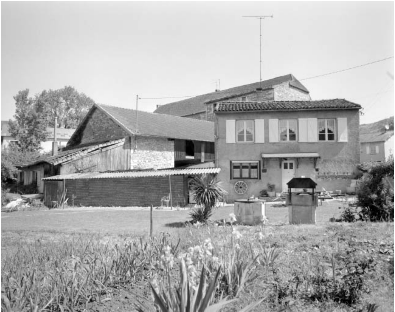
Parties agricoles et logement depuis le sud-ouest.
