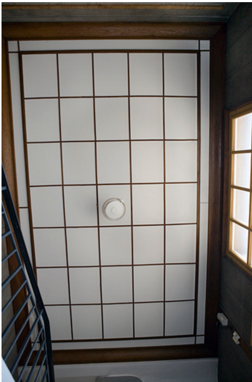
Cage d'escalier : plafond du hall.
