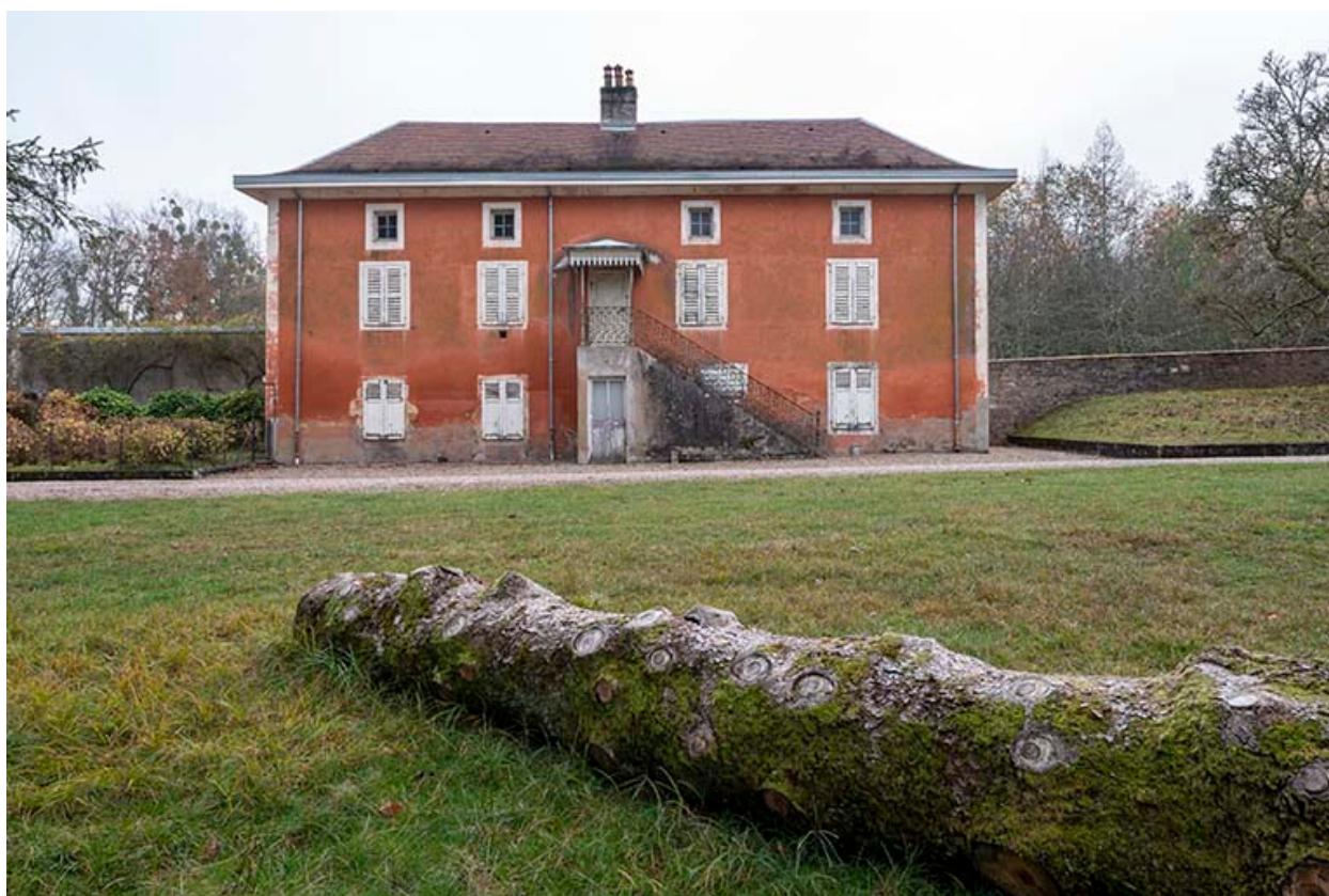
Façade nord, vue d'ensemble.
