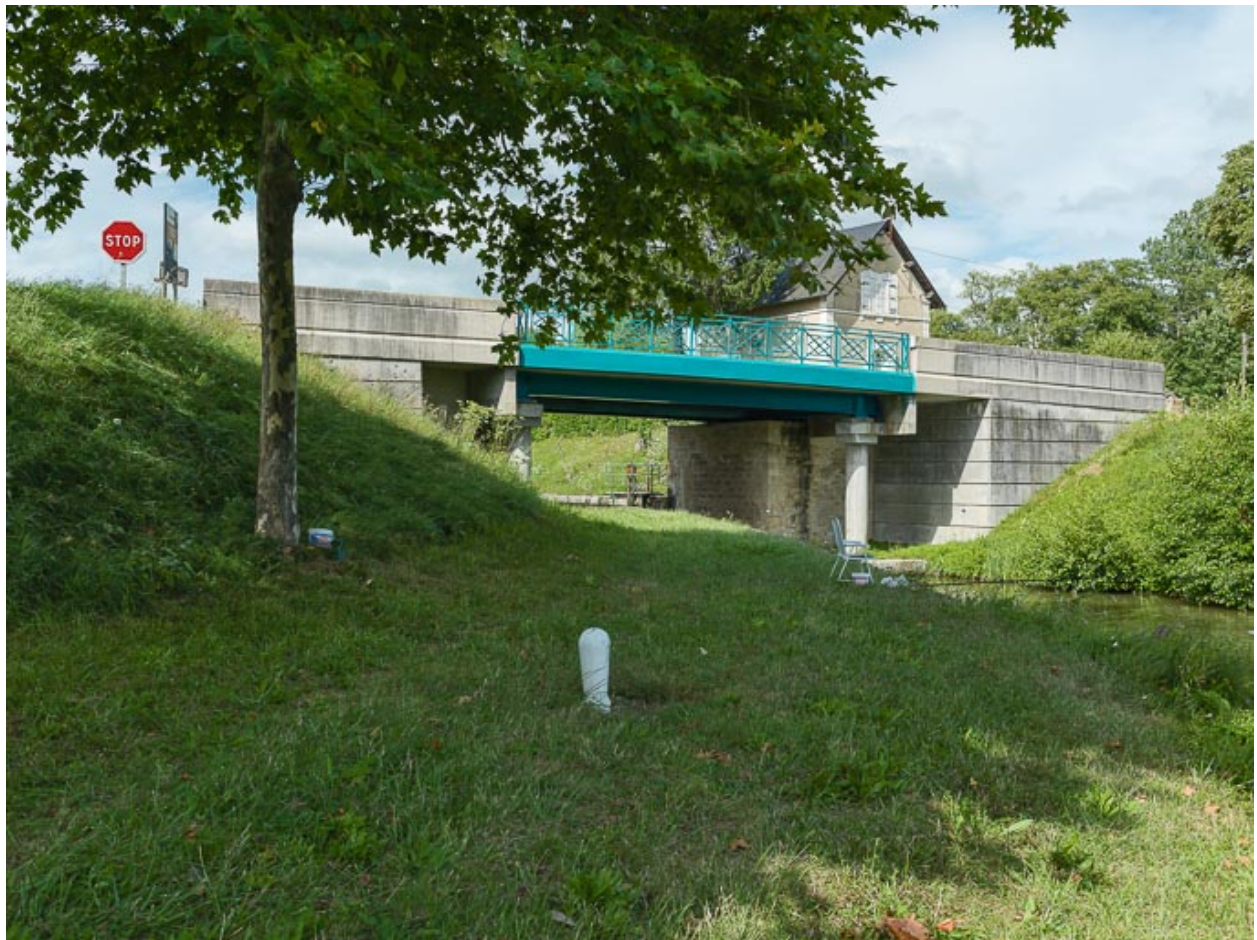
Vue d'ensemble du pont.
