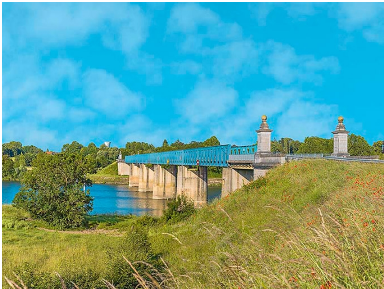
Vue d'ensemble du pont, d'aval.
