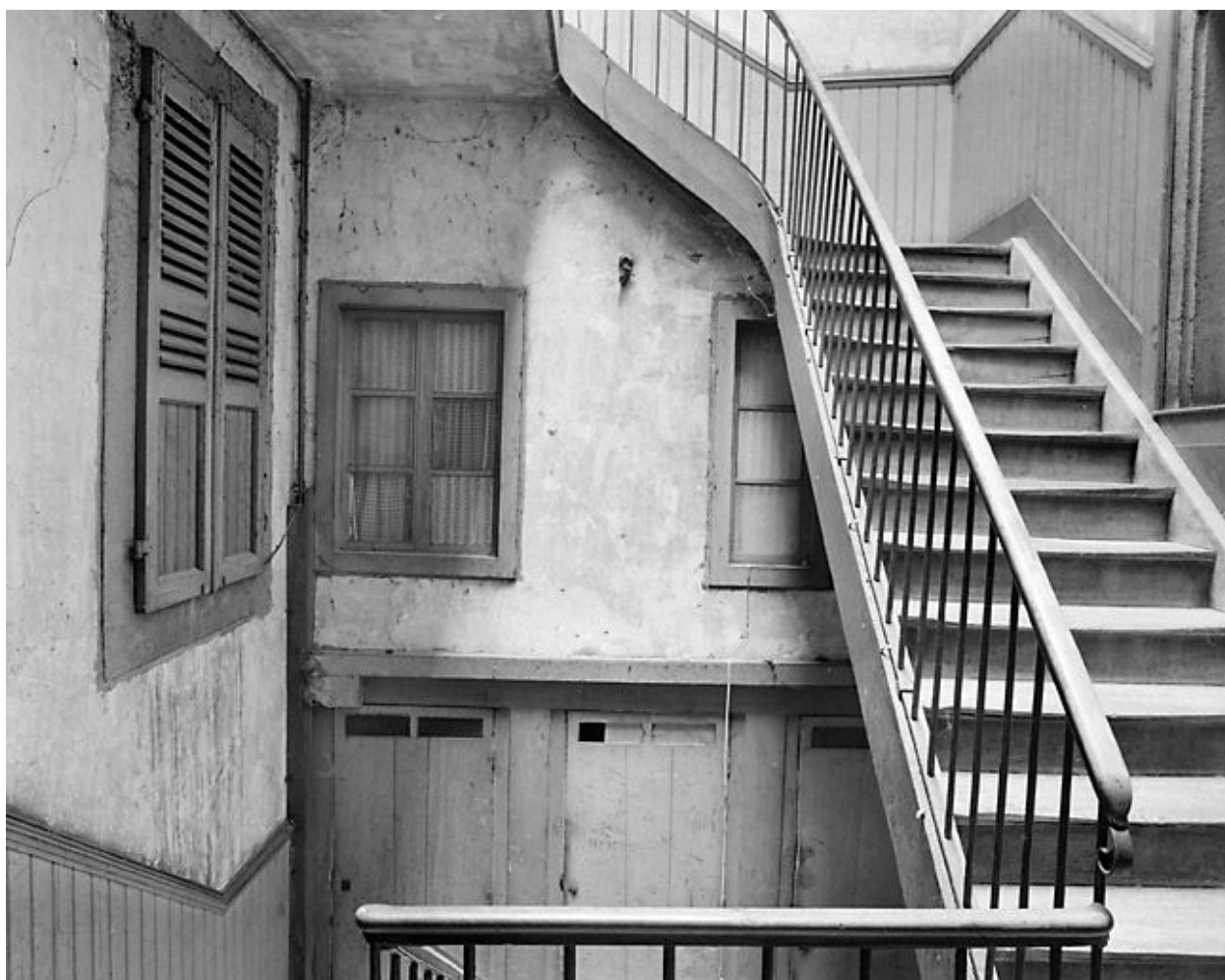
Cage d'escalier, au premier étage.
