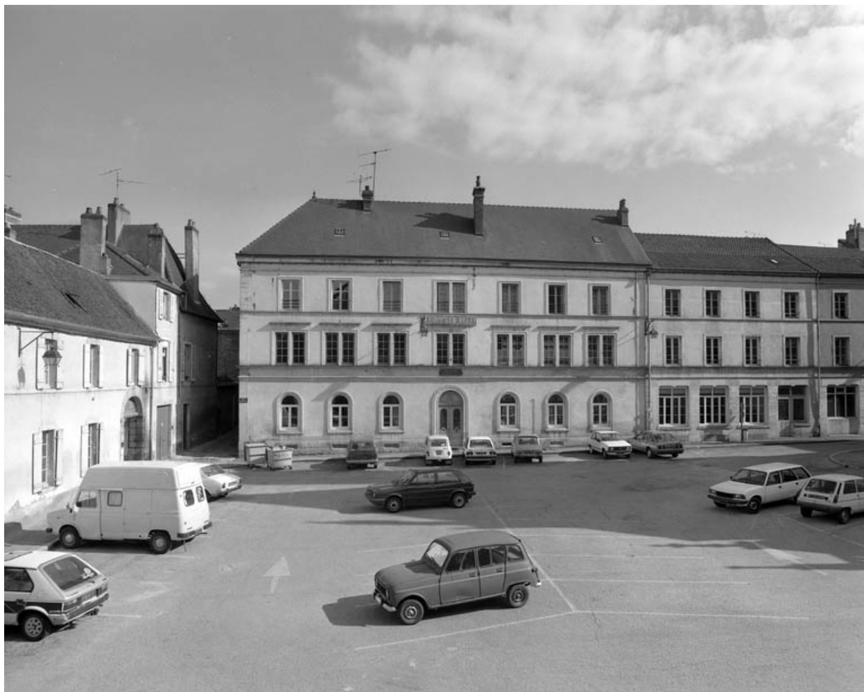
Façade antérieure de face : vue éloignée.
