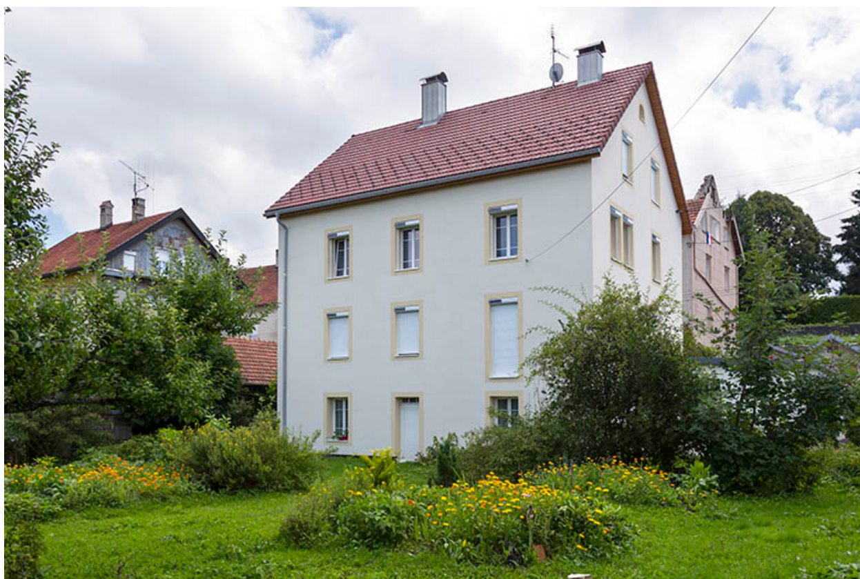
Façades postérieure et latérale gauche.
