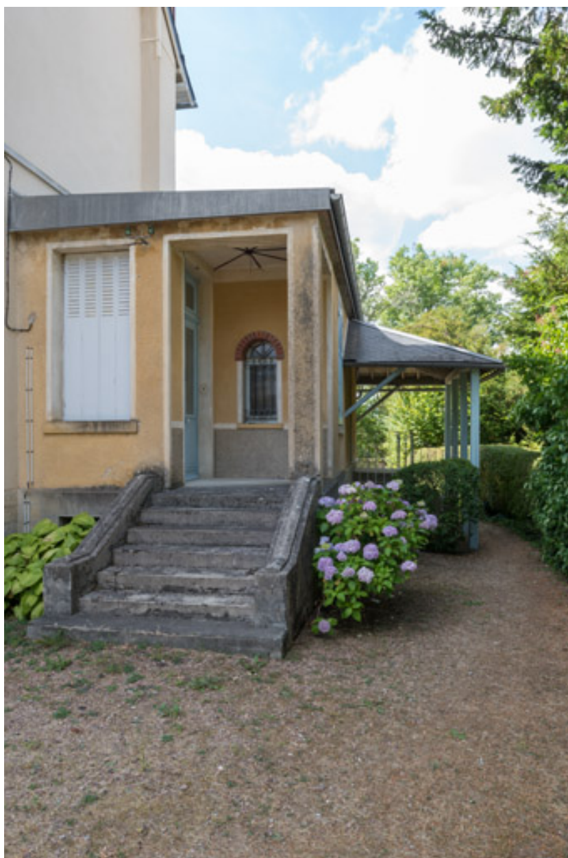
Entrée latérale, côté nord.
