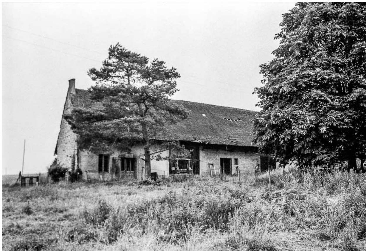
Ferme cadastrée 1969 AL 20 : façade antérieure.
