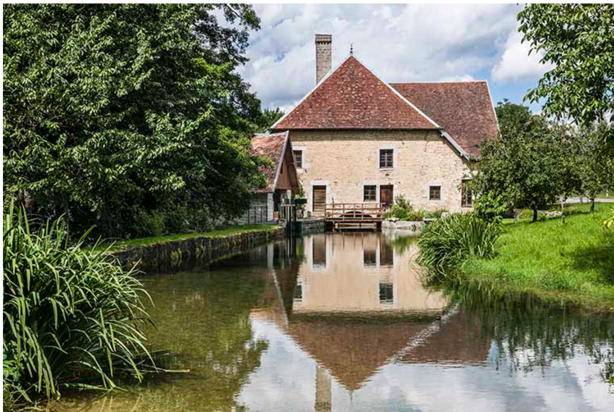
Vue d'ensemble depuis l'amont.
