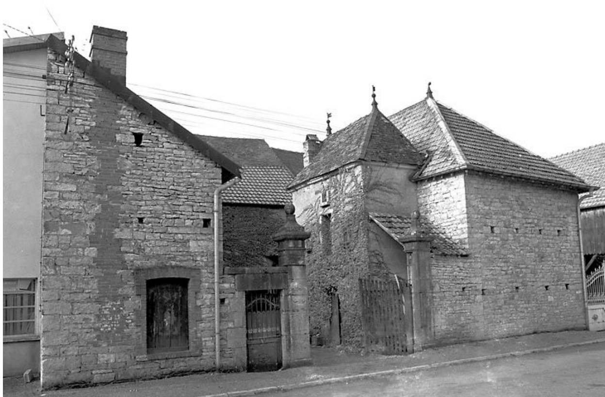
Ferme située 17-19 rue de la Gare.
