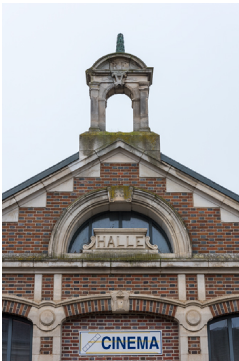
Façade antérieure : décor du pignon (cadrage vertical).
