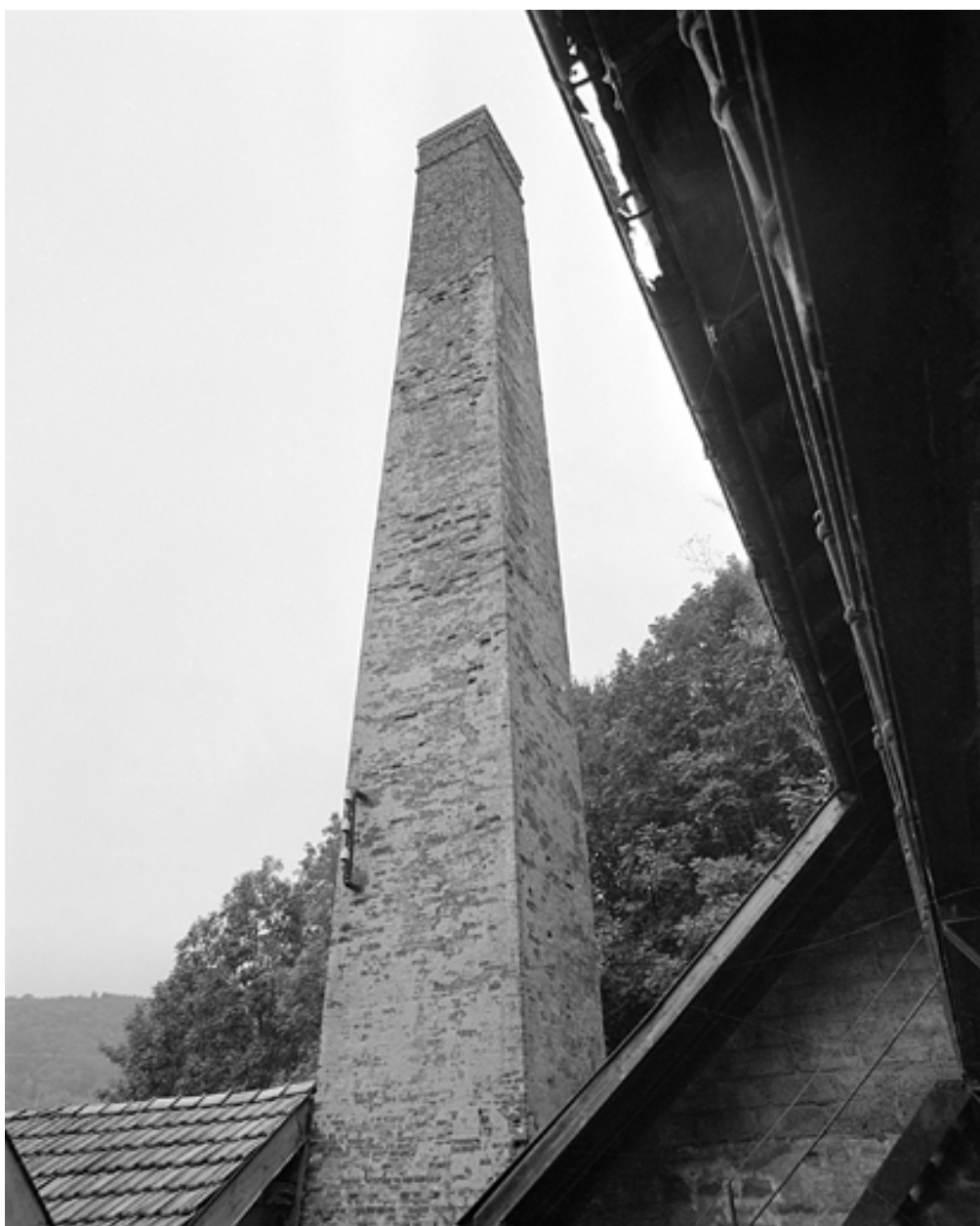
Cheminée de la chaufferie.
