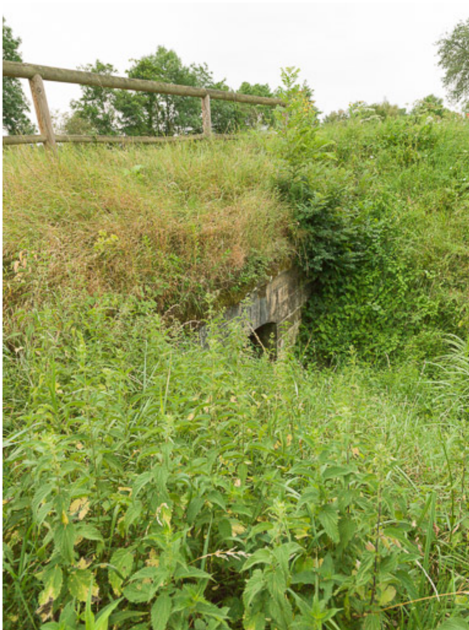
Vue de l'aqueduc.
