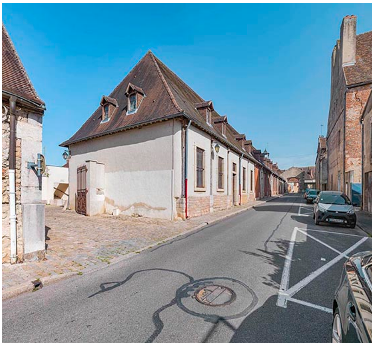
Le hangar depuis la rue des Halles.
