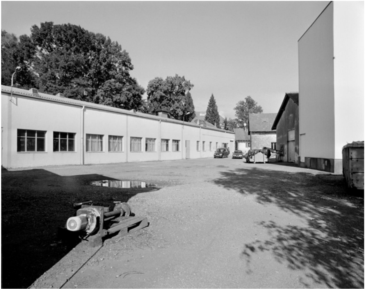
Atelier de fabrication depuis le sud-est.
