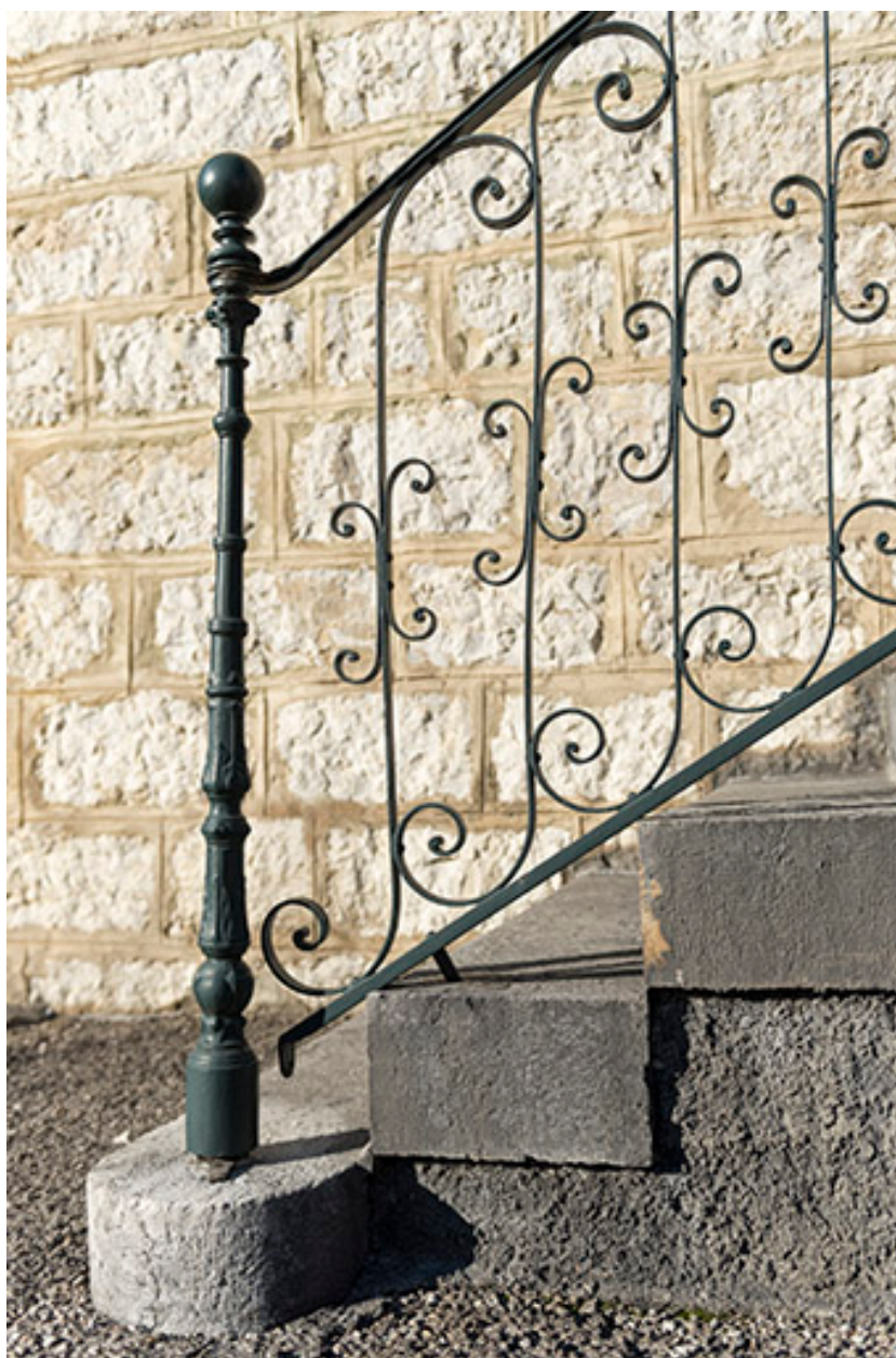
Façade antérieure : garde-corps de l'escalier.
