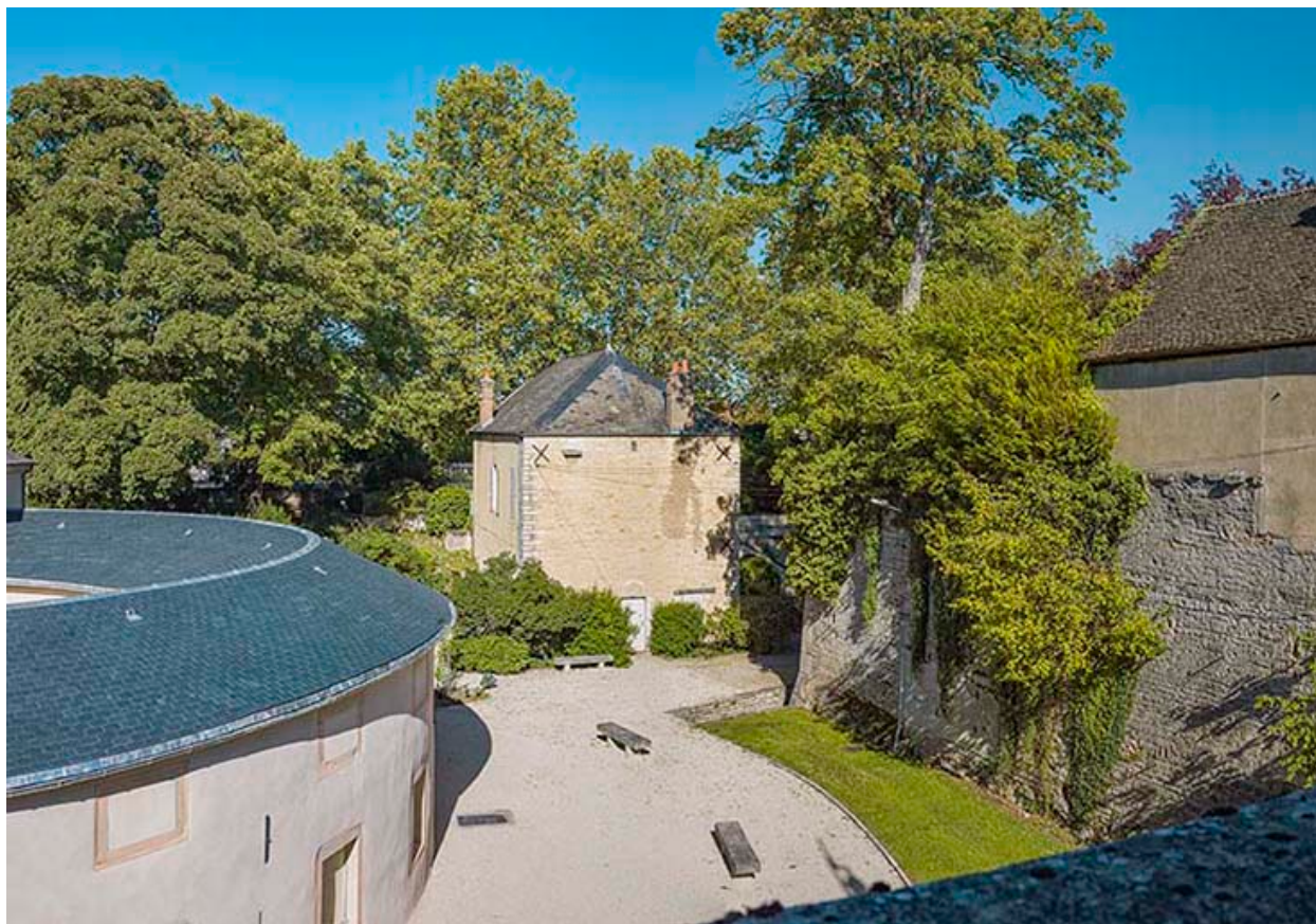
Flanc ouest du bastion.
