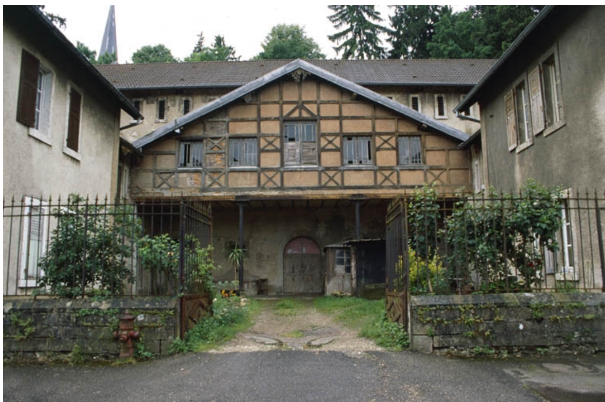
Façade nord de l'écurie.
