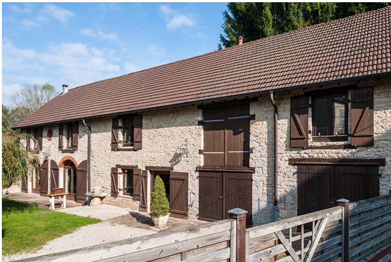
Bâtiment de la forge. Façade ouest.
