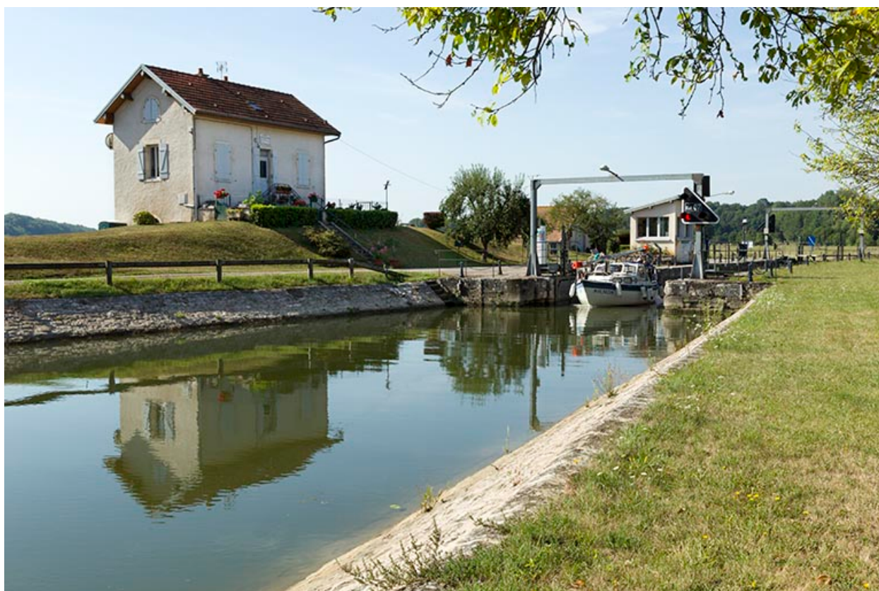
Site d'écluse de Sacey-sur-Saône (70).
