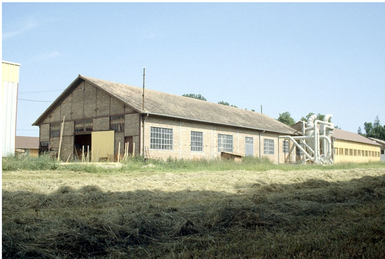
Atelier de fabrication (K), depuis le sud.
