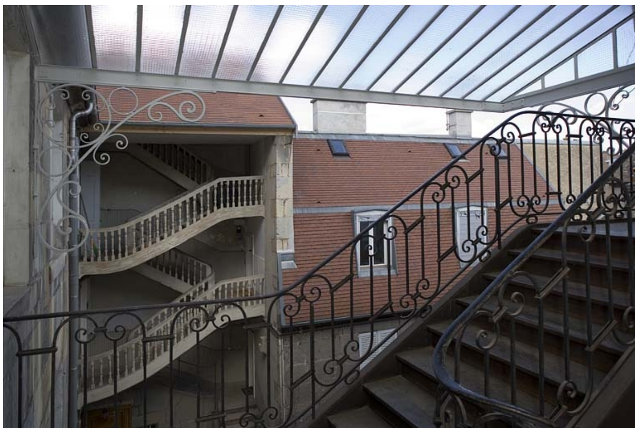
Détail de l'escalier droit depuis l'escalier gauche.
