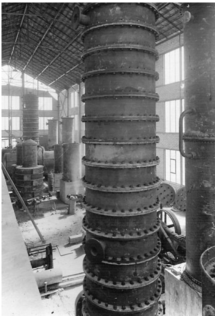
[Creveney] Intérieur de la raffinerie [de la Société des Schistes et Pétroles de Franche-Comté]. Colonnes de distillation, 1933.
