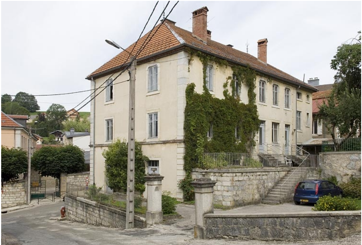
Façades postérieure et latérale droite.
