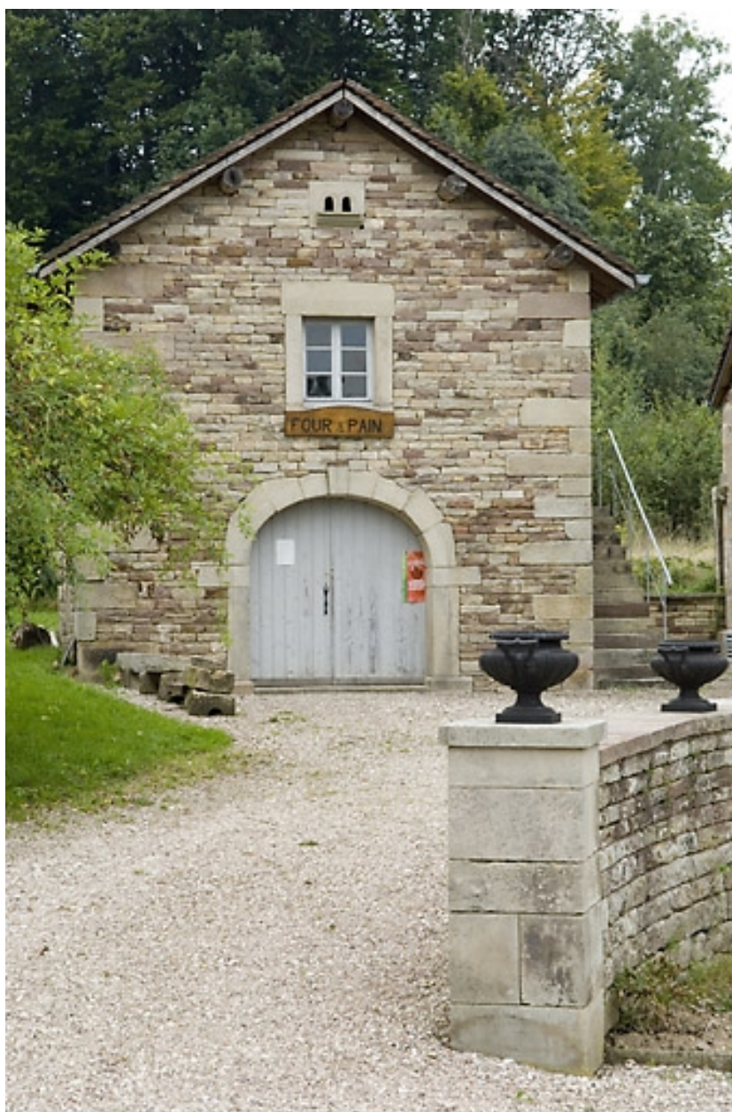
Four à pain. Vue de face.
