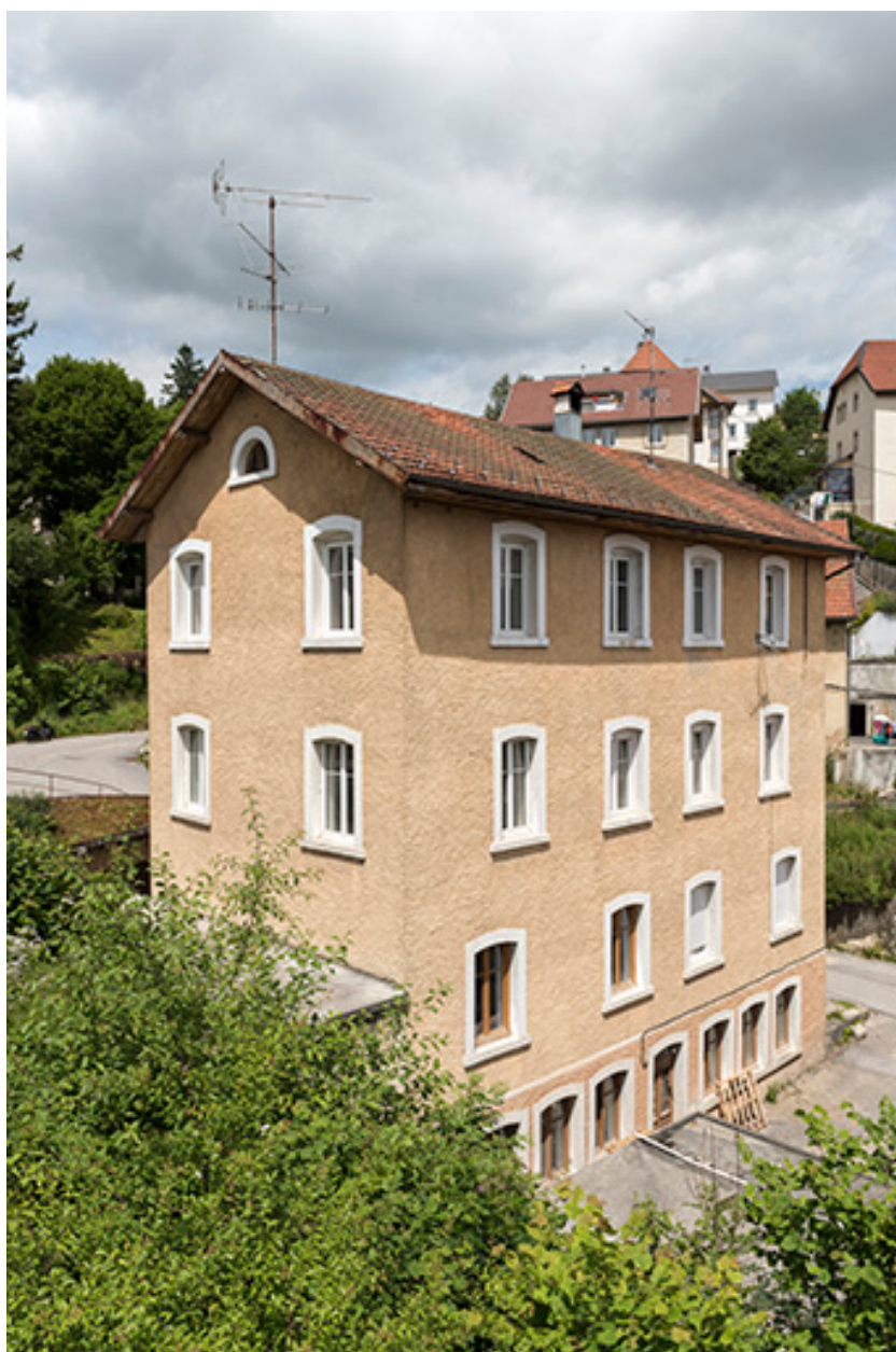
Façades postérieure et latérale droite.
