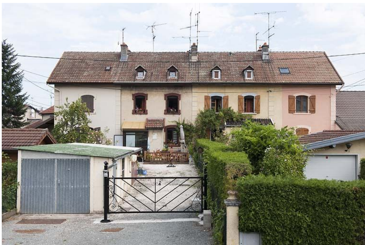
Habitation à 8 logements. Vue de face.
