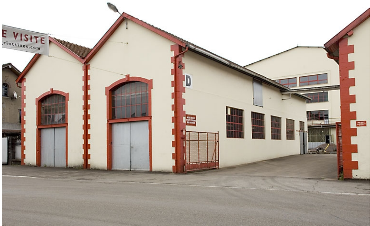
Atelier de réparation. Vue de trois quarts.
