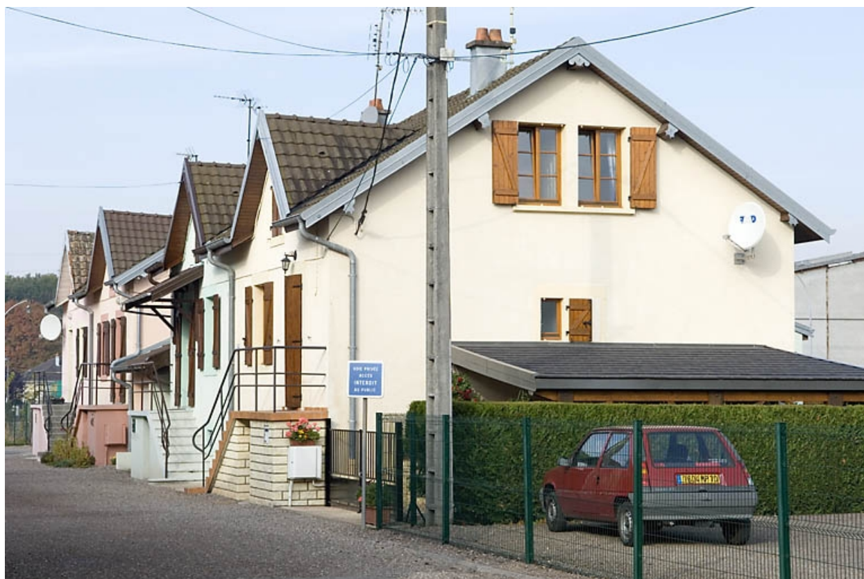
Logements doubles. Vue en enfilade depuis l'est.
