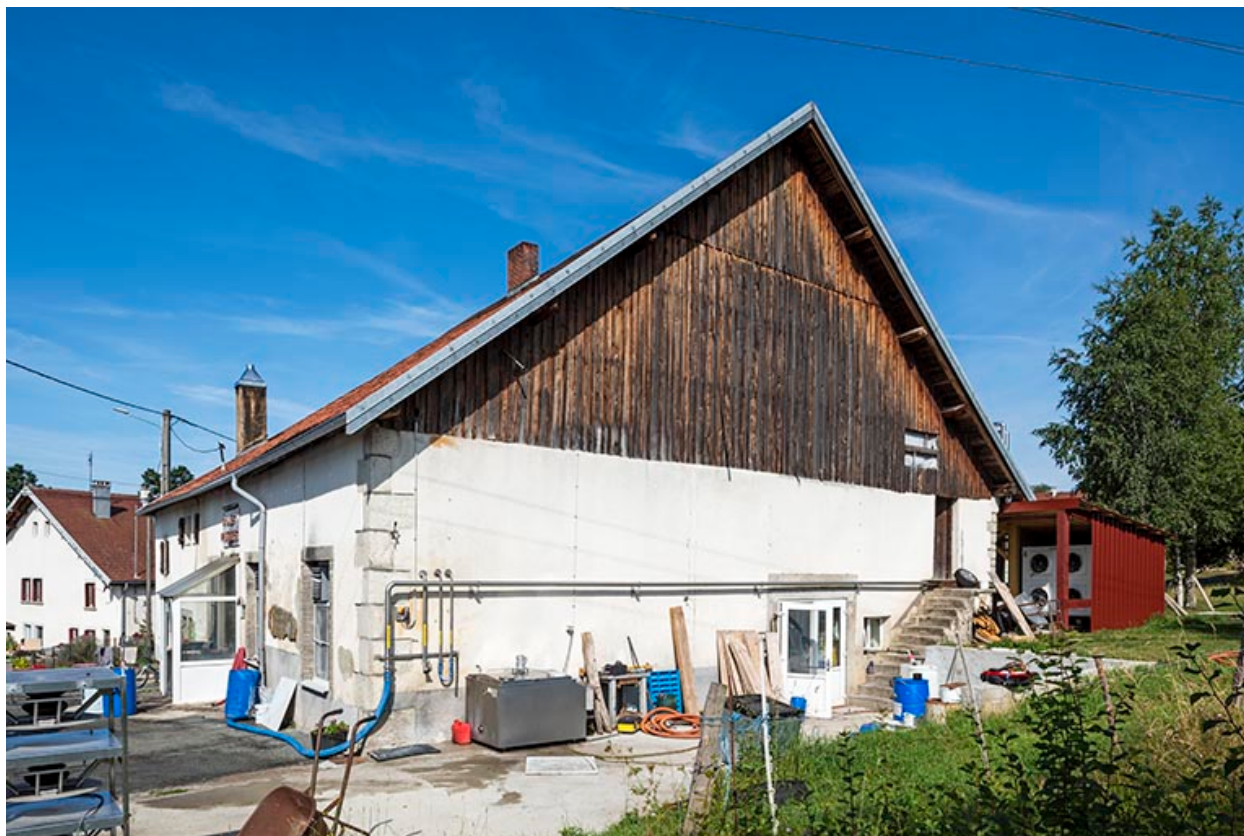
Façade latérale droite, de trois quarts.
