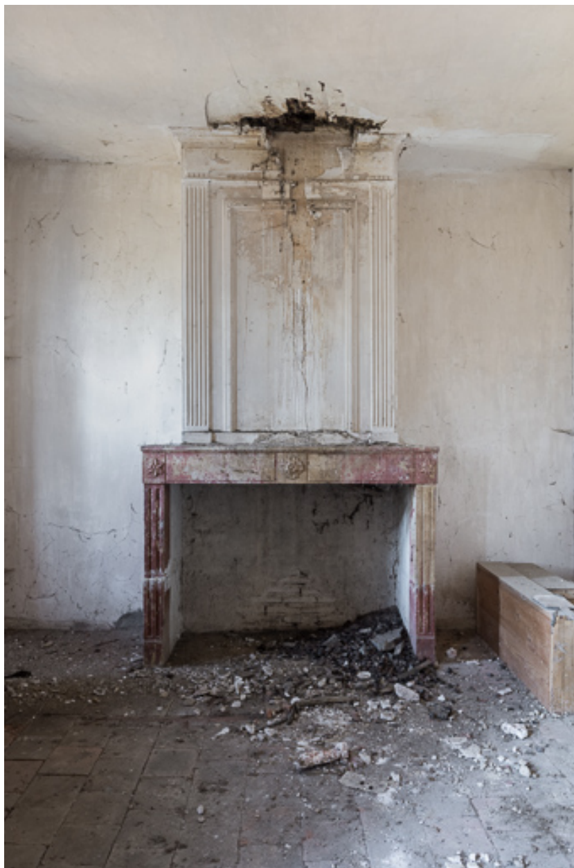
Vue de la cheminée de cette chambre
