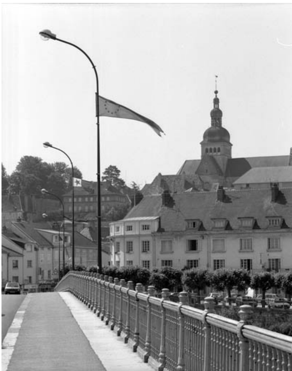
Vue du garde-corps en fonte.
