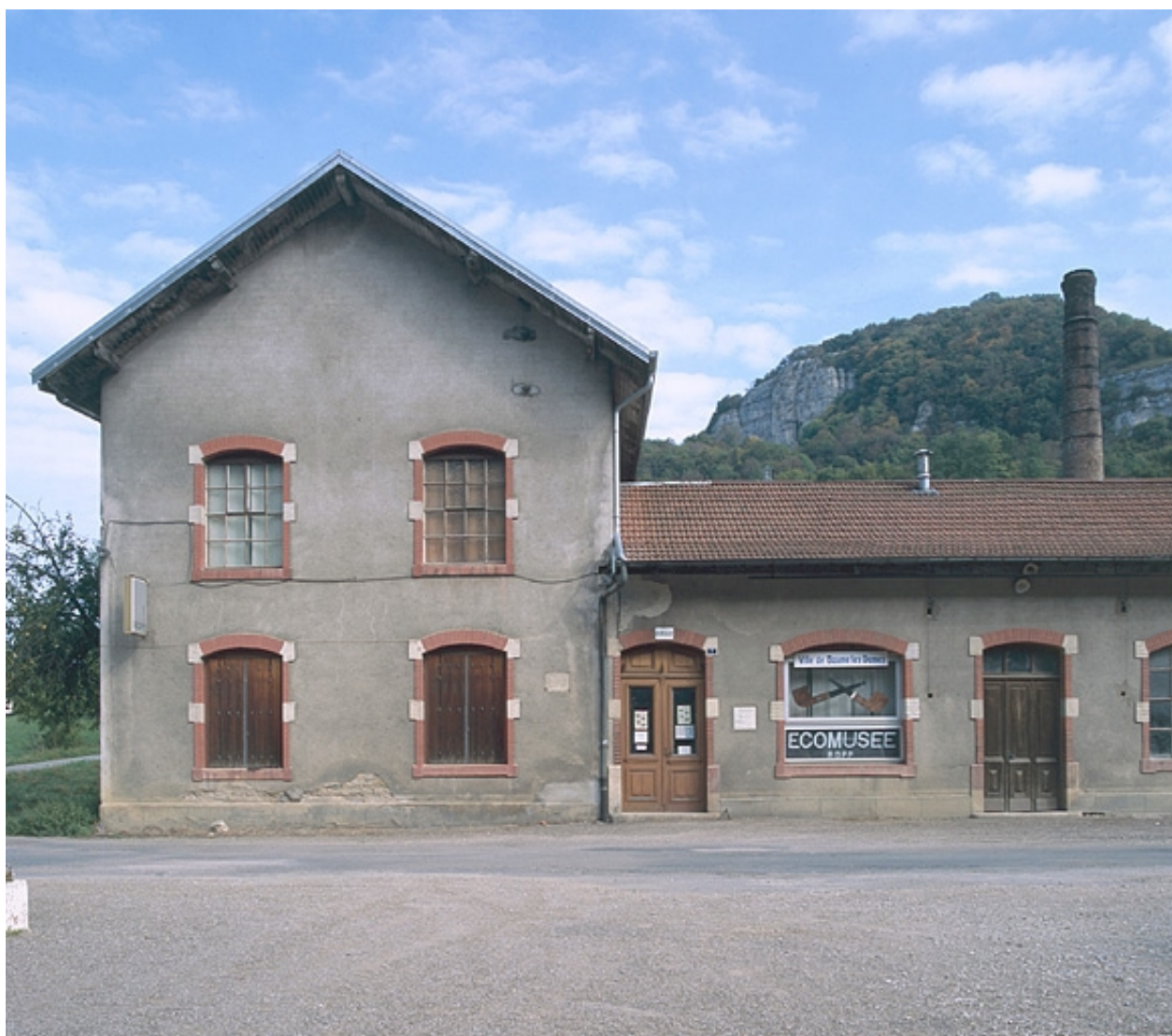
Façade antérieure du bâtiment à étage.
