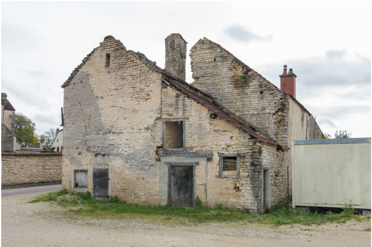
Vue du mur pignon sud.
