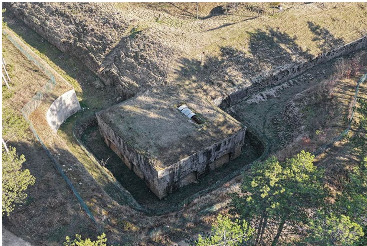
La double caponnière, au saillant 3. (vue aérienne).
