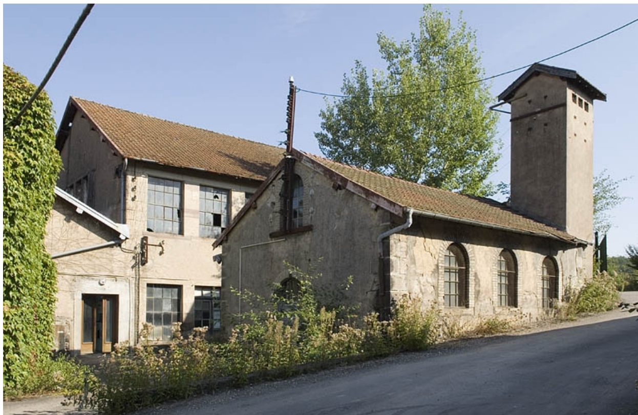
Local technique et transformateur électrique à l'entrée.
