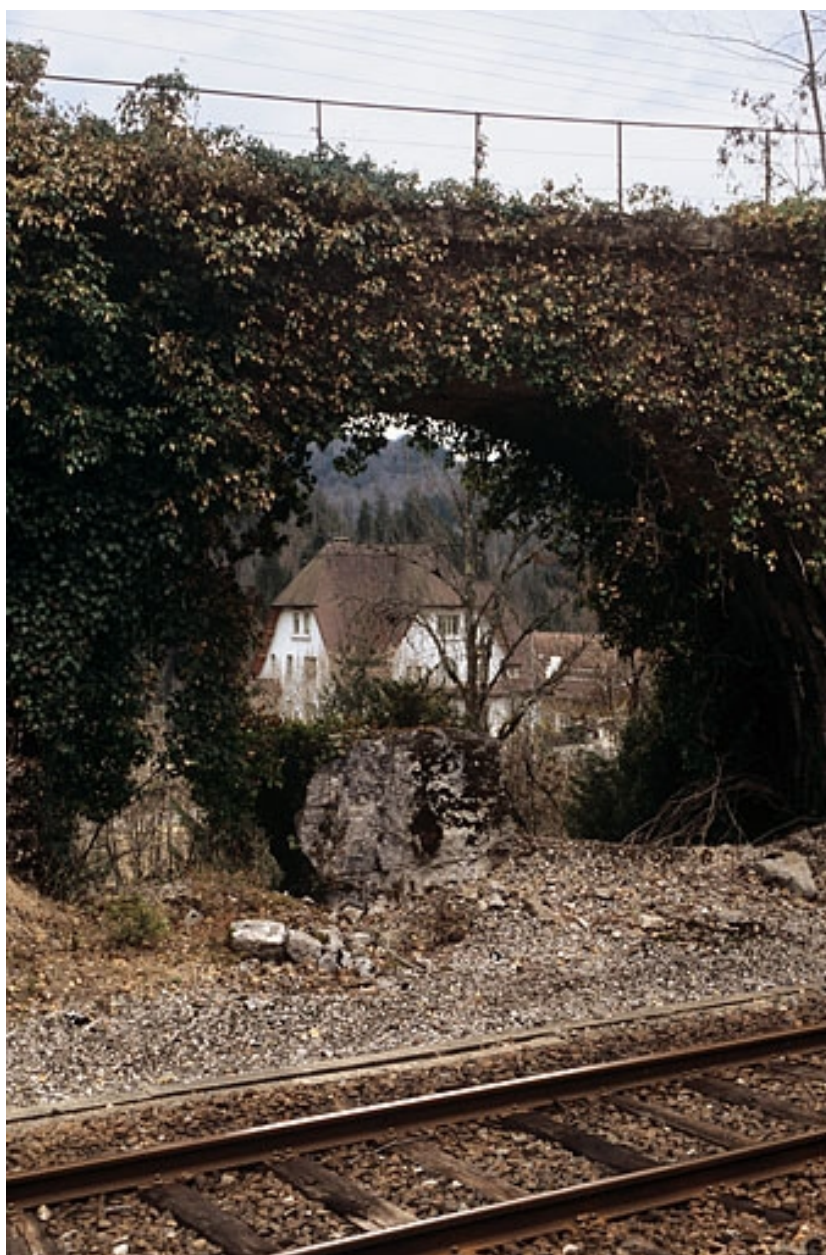
Pont du tacot : arche en plein-cintre.
