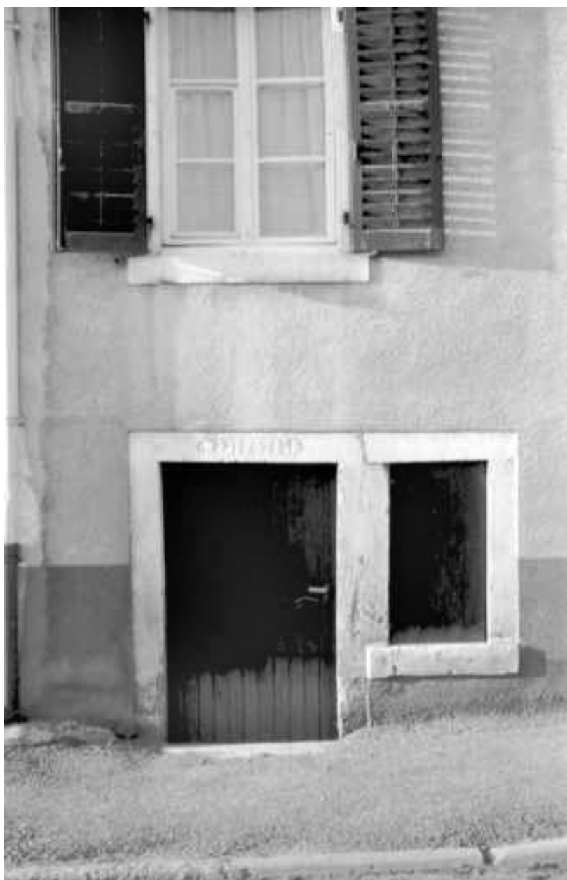
Détail du pignon sur rue.
