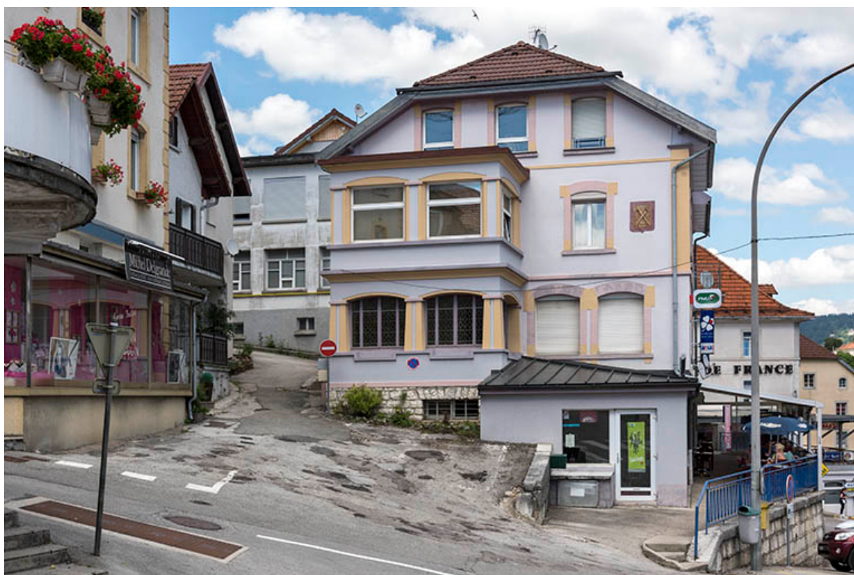
Façade latérale gauche.
