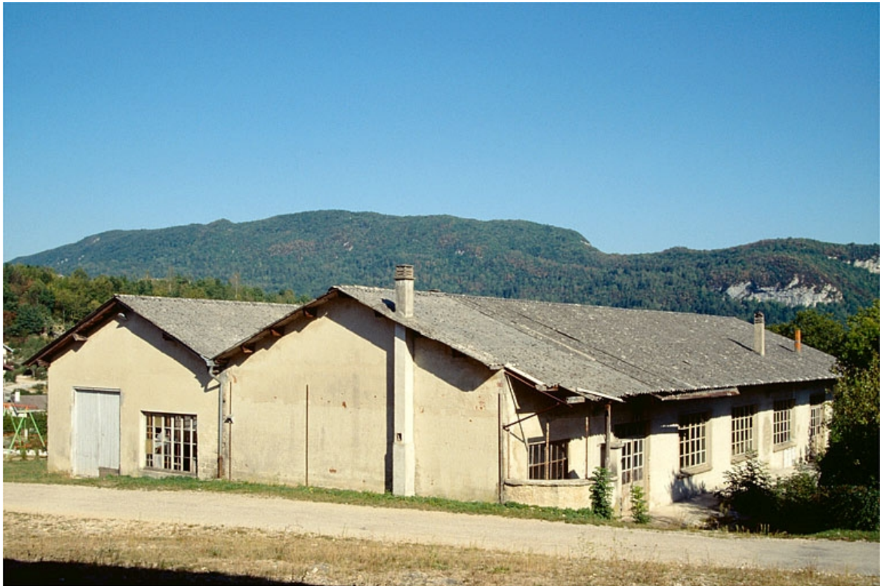
Atelier de fabrication (scierie), vu depuis l'ouest.
