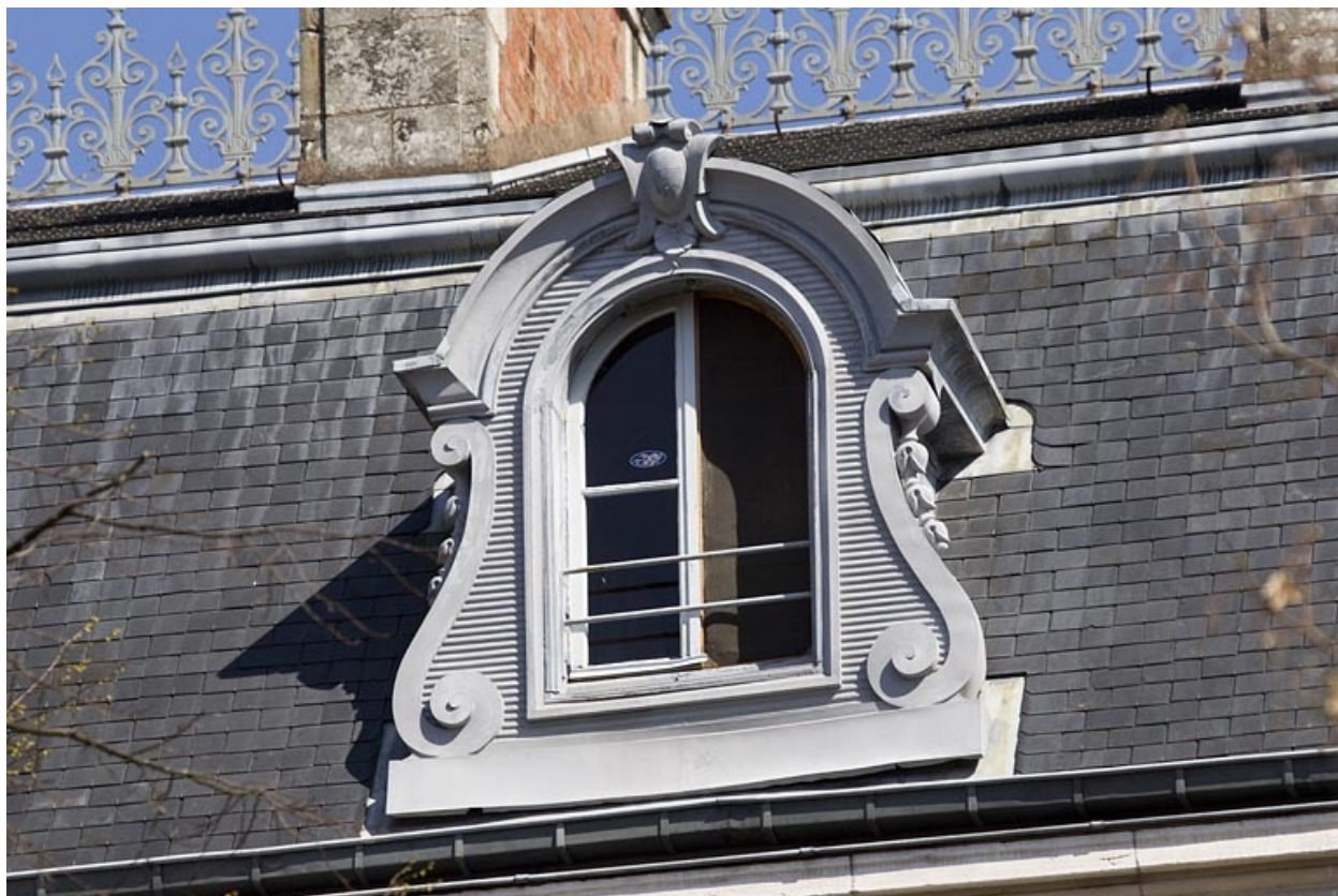
Toiture : détail d'une lucarne.
